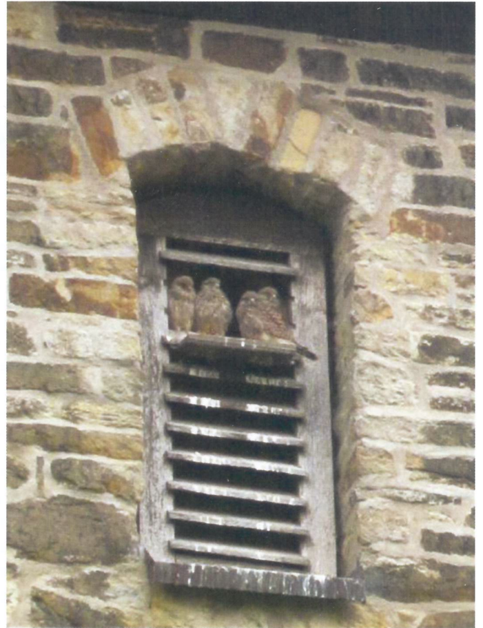
Die Turmfalken haben sich ein sicheres und geschütztes Quartier ausgesucht.
